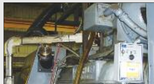
Generadores Stat-X que protegen la máquina CNC con una unidad de aerosol montada externamente.
