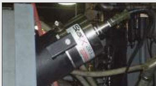
Generadores Stat-X que protegen la máquina CNC con una unidad de aerosol montada externamente.
